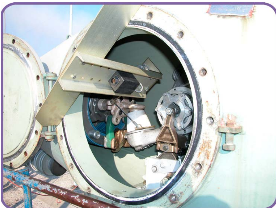
Figura 29. Instalación de Transductor en un interruptor Westinghouse SFA
