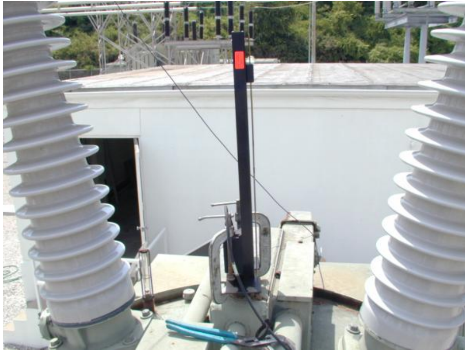
Transductor Lineal montado en un OCB
